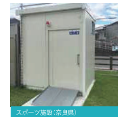
スポーツ施設(奈良県)
