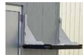
[ エアコン室外機架台 ]
