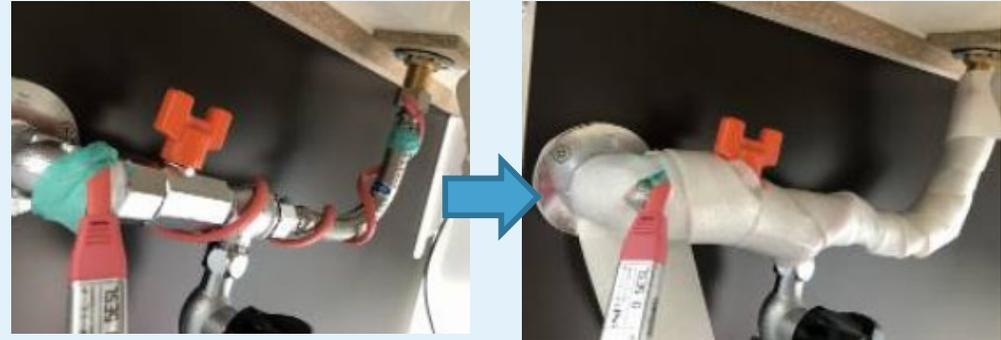
手洗下 室内給水管にヒーターを施工
