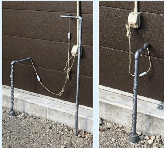
給水管にヒーターを施工
