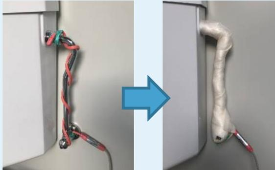
ロータンク給水管にヒーターを施工
