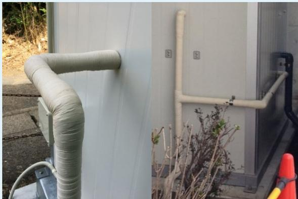
給水管に保温材を施工
